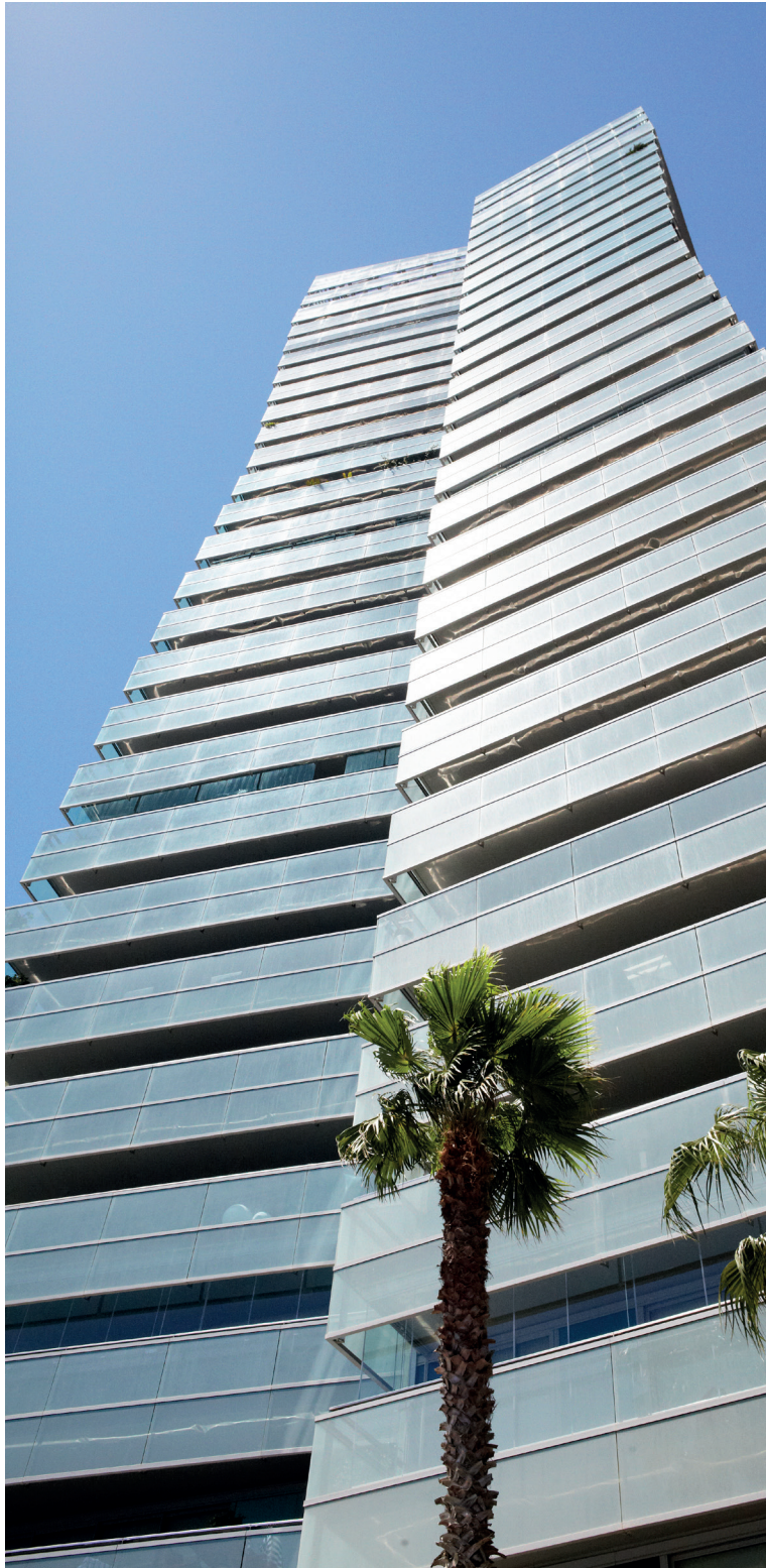
Housing Viviendas Illa del Mar, Barcelona
