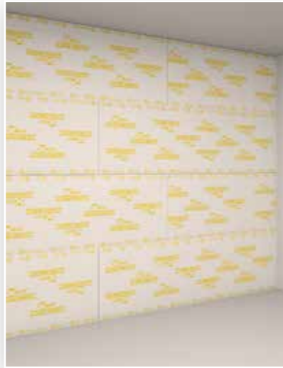
2._ Ploče ugrađene vodoravno
