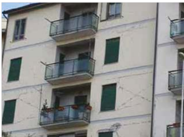
Mehanizam oštećenja kod djelovanja u ravnini - SLD
