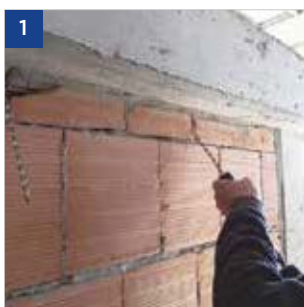
Pričvršćivanje pomoću čeličnih konektora
