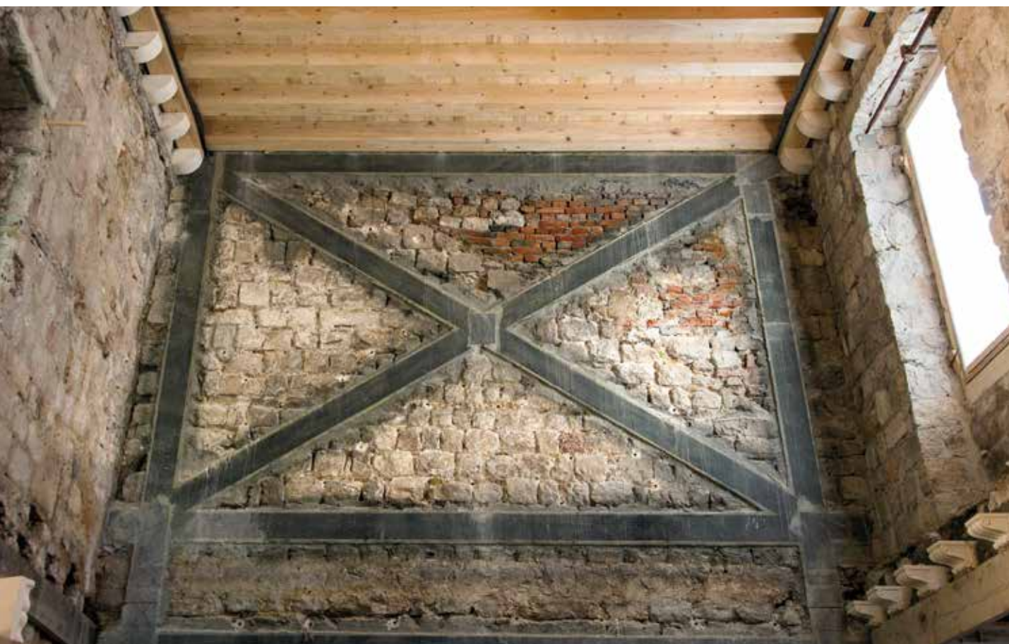
Ojačanja sustavom CFRP
