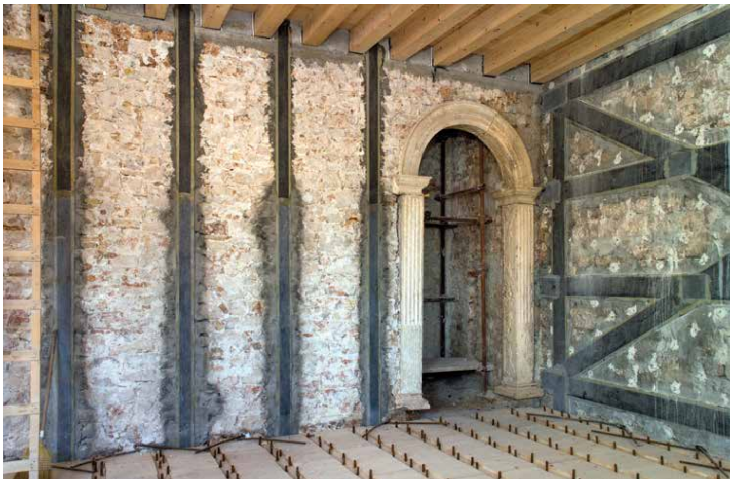
Ojačanja zida za opterećenja u ravni i van ravni sustavom CFRP
