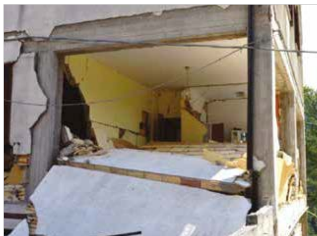
Mehanizam urušavanja kod djelovanja izvan ravnine - SLU
