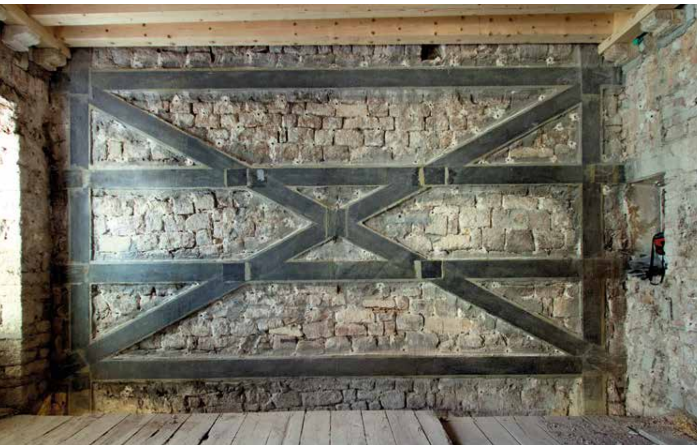
Ojačanja sustavom CFRP
