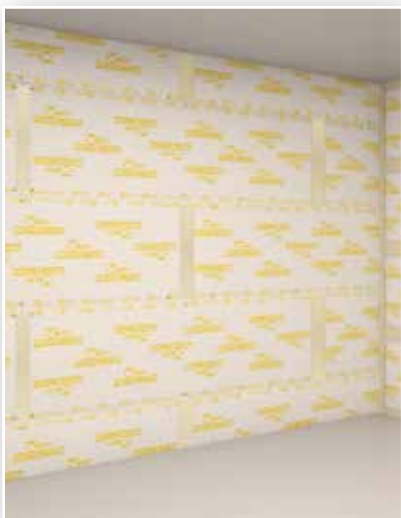
7._ Okomiti spojevi drugog sloja
