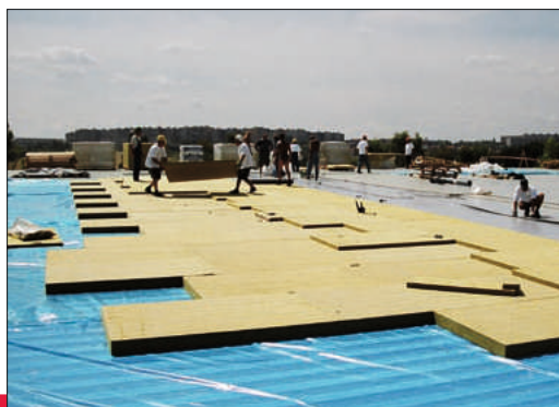
Primjer ugradnje proizvoda Isover S
